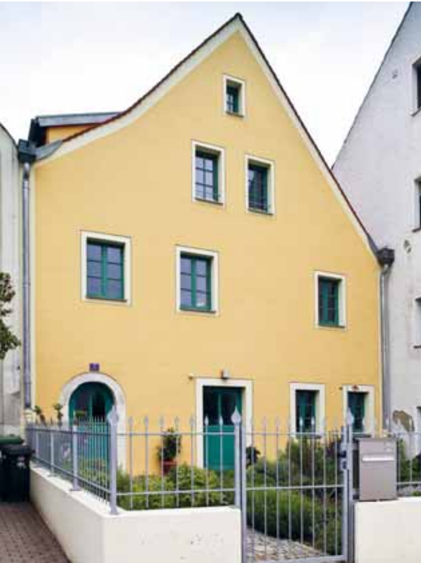
↓ Werftstraße 5 nach Sanierung
