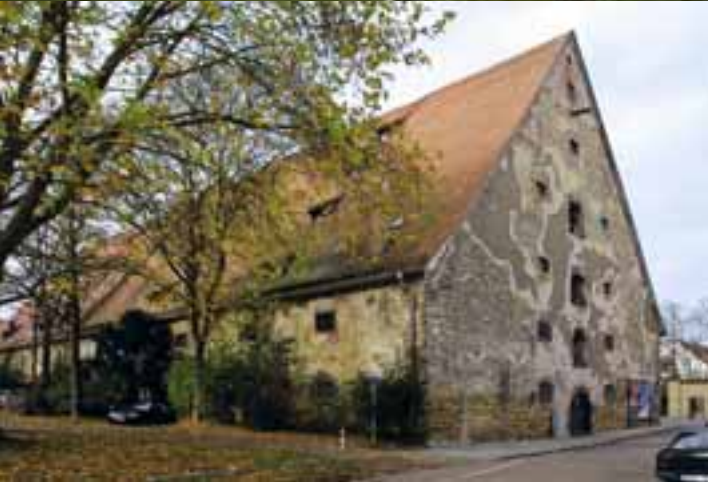
Andreasstadel vor der Sanierung
