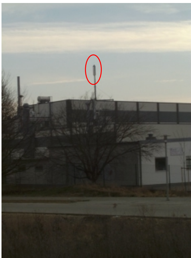
Bild 6: Mobilfunkanlage, vom Messpunkt 4b aus gesehen
