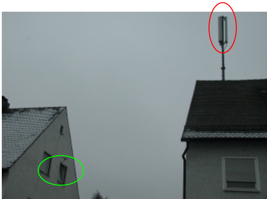
Bild 1: Messpunkt 2 mit Mobilfunkantenne auf dem Nachbarhaus
