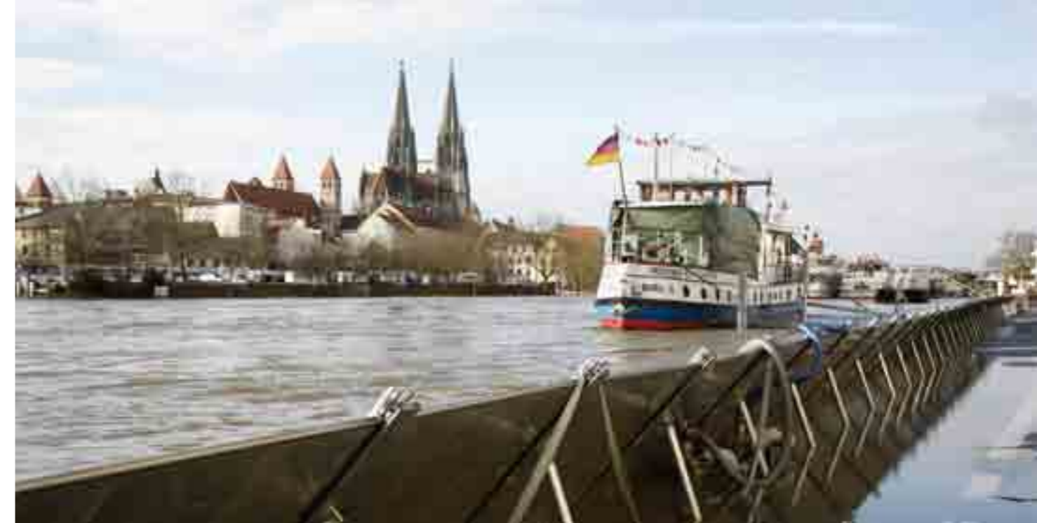
→ MOBILES HOCHWASSERSCHUTZSYSTEM AN DER WERTSTASSE, 2011
