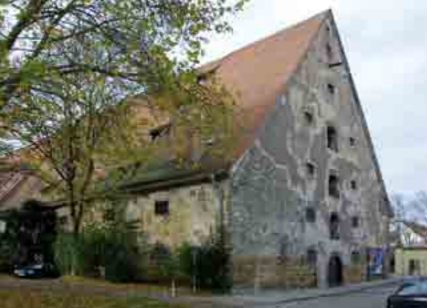
➤ ANDREASSTADEL VOR UND NACH DER SANIERUNG
