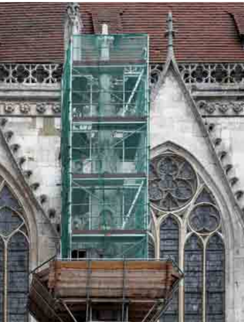
INSTANDHALTUNGSARBEITEN AM DOM
