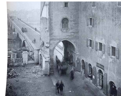
Verbreiterung der Zufahrt zur Brücke
