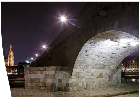
Neue Beleuchtungssituation nach der Sanierung
