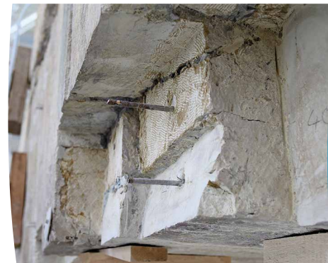
Die neuen Quader müssen sicher verankert werden
