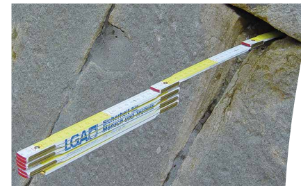
Offene Mauerwerksfugen
