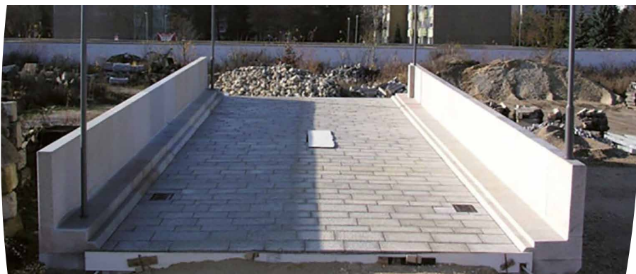
Das Musterbauwerk am Bauhof Nord
