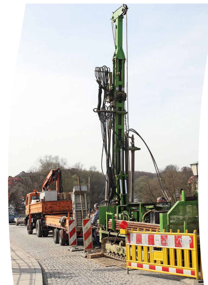
Mit schwerem Gerät wird bis ins Innerste der Brücke vorgedrungen
