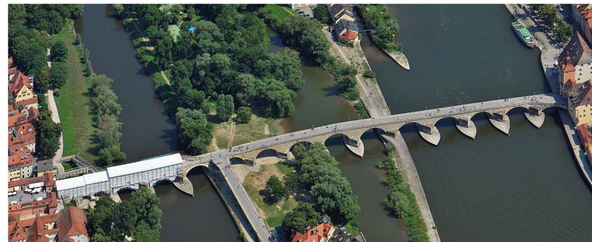
Einhausung der Steinernen Brücke
