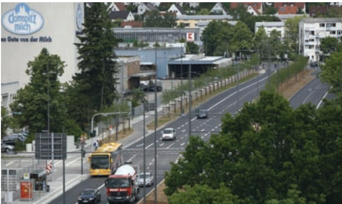
Abbildung 11: Panoramafoto - Die neue Nordgaustraße
