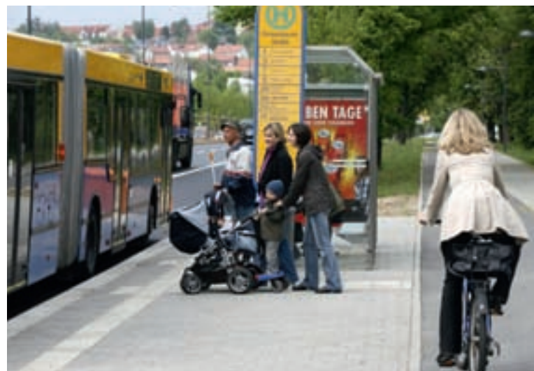
Abbildung 3: Bushaltestelle mit taktilem Gehwegbelag
