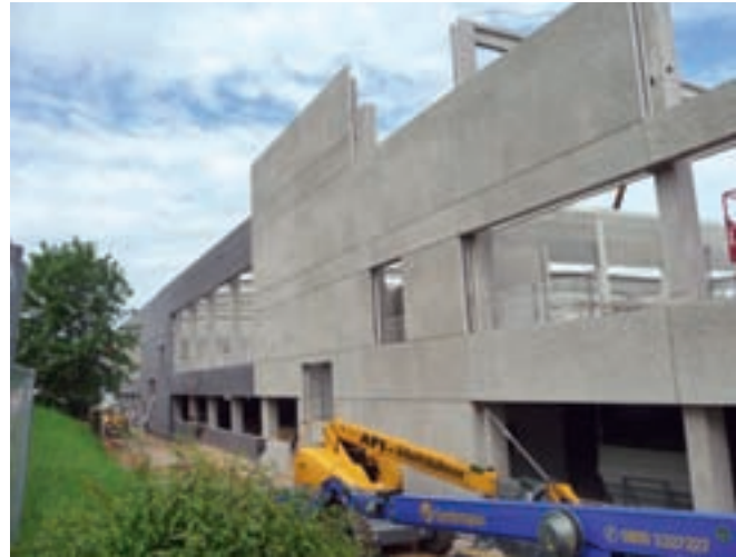
Abbildung 7: Baustelle im Mai 2009
