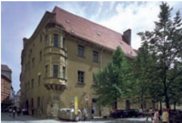
Abbildung 2: Das Anwesen vor der Sanierung
