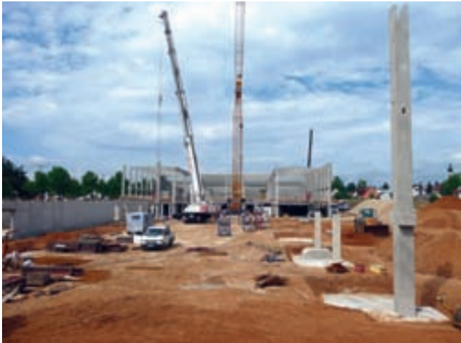
Abbildung 6: Baustelle im April 2009
