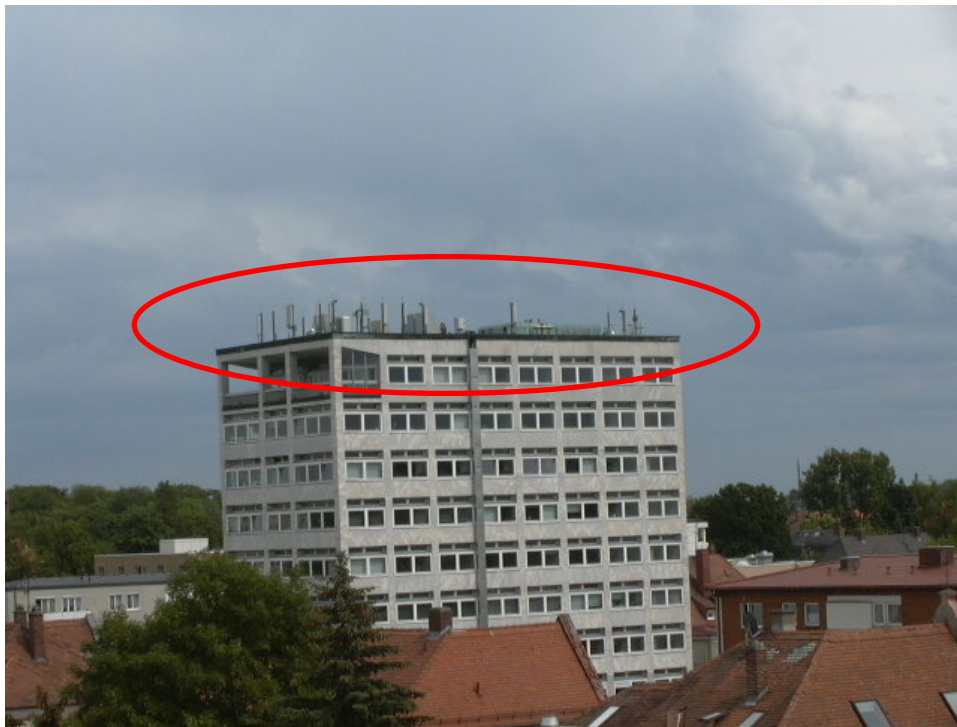
Bild 1: Anlagenstandort, von Messpunkt 1 aus gesehen
