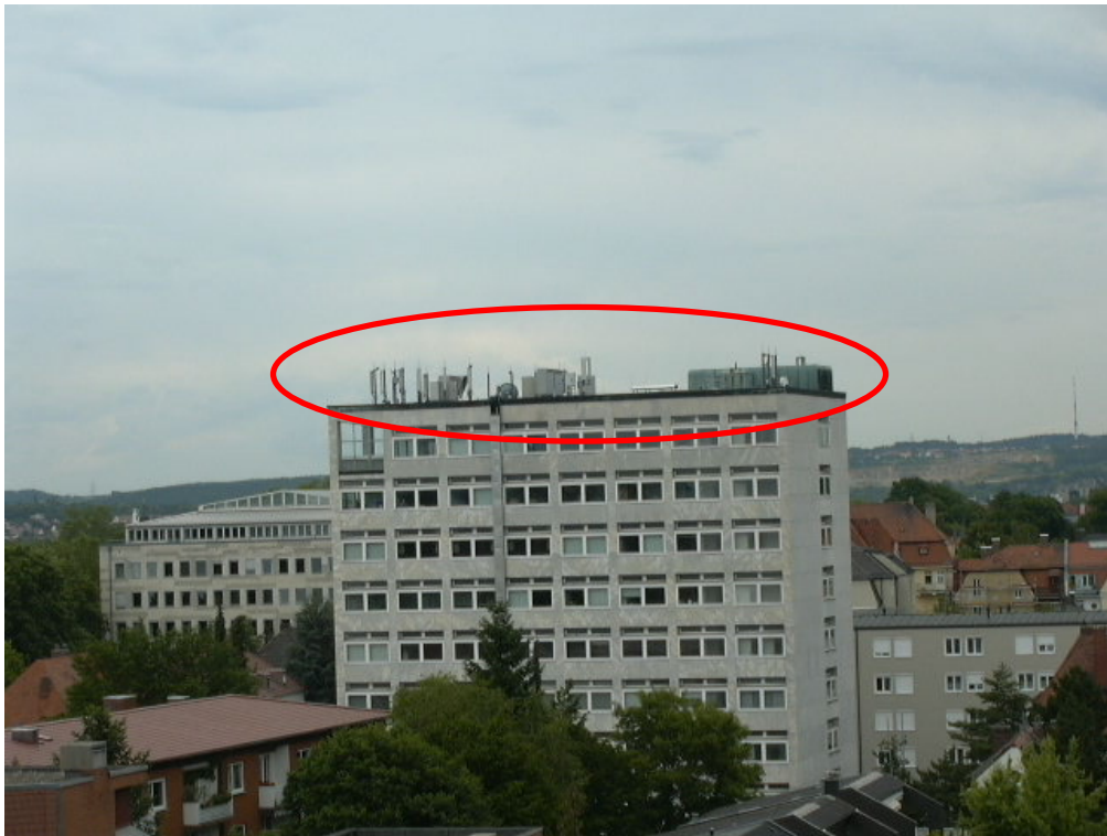
Bild 5: Anlagenstandort, von Messpunkt 5 aus gesehen
