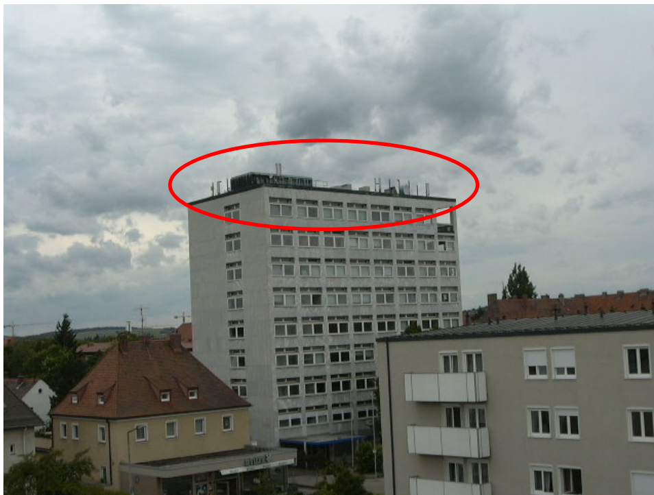
Bild 2: Anlagenstandort, von Messpunkt 2 aus gesehen
