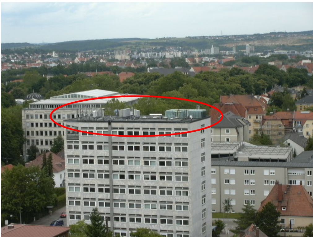
Bild 4: Anlagenstandort, von Messpunkt 4 aus gesehen
