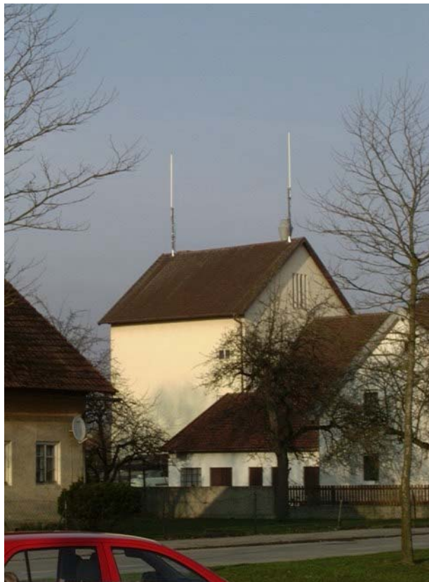
Abb. 1: Beispiel für eine Mobilfunksendeanlage mit omnidirektionalen Antennen
