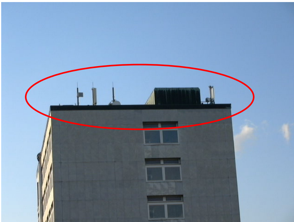
Bild 8: Anlagenstandort, von Messpunkt 8 aus gesehen
