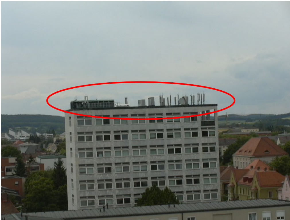
Bild 3: Anlagenstandort, von Messpunkt 3 aus gesehen
