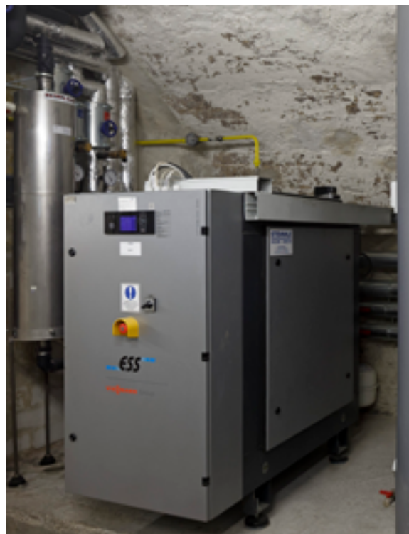
Abb. 12.1: Blockheizkraftwerk
