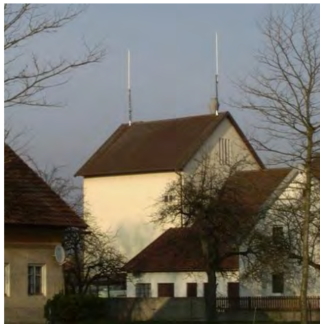
Abb. 2: Beispiel für eine Mobilfunksendeanlage mit omnidirektionalen Antennen.
